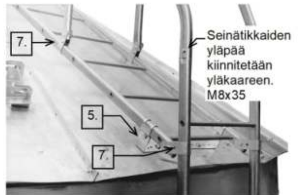
Kuva 11. Kattotikkaiden alapään ja kaiteiden kiinnitys.
