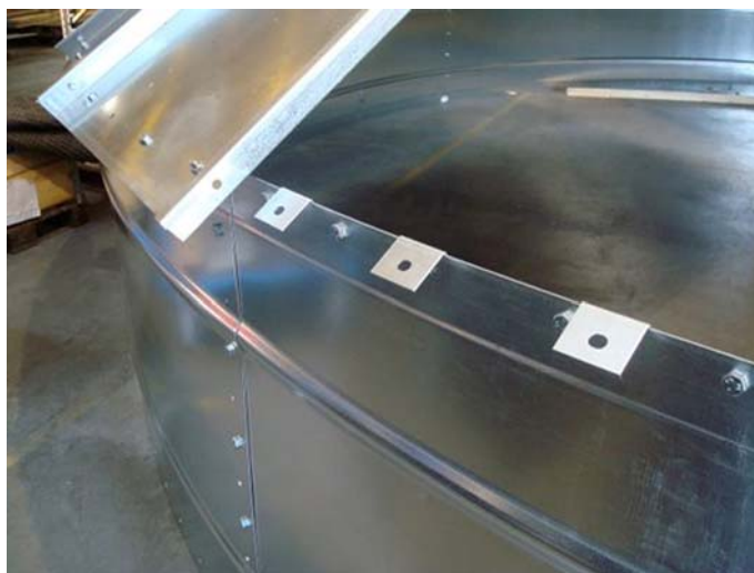
Kuva 5, Ylävanne kiinnitetään sisäpuolelle
