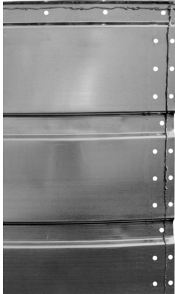
Kuva 4. Tiivistemassan levitys seinäelementtiin. Massaa voidaan käyttää myös aluslevyjen yhteydessä.
