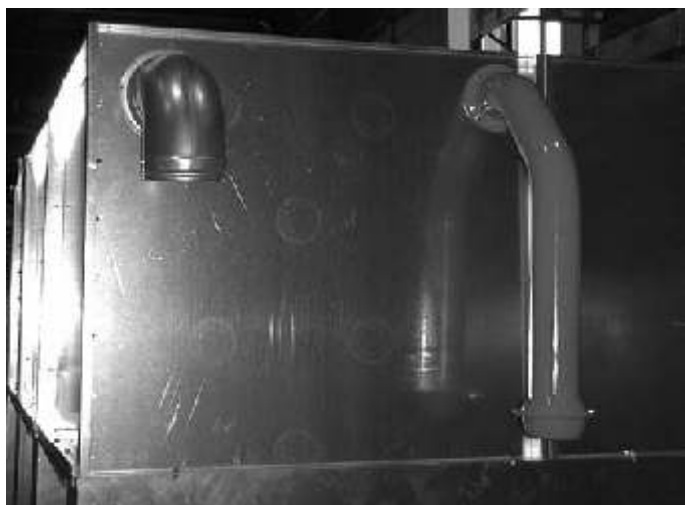
17. Asenna täyttöputki ulkoa päin reikään.
