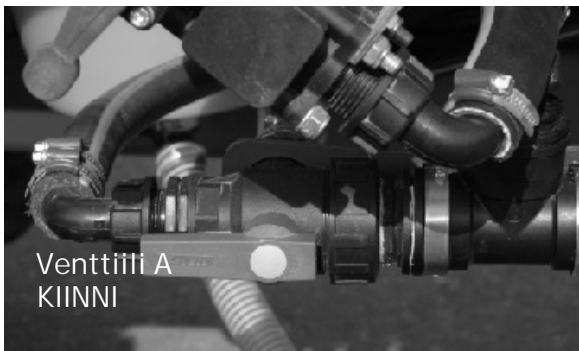
Kuva 7. Venttiili A suljettu.
