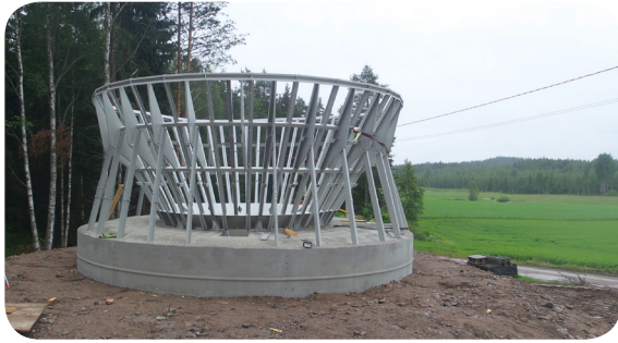
Kuvassa reunakartioiden elementit asennettu pohjasuppiloon.
